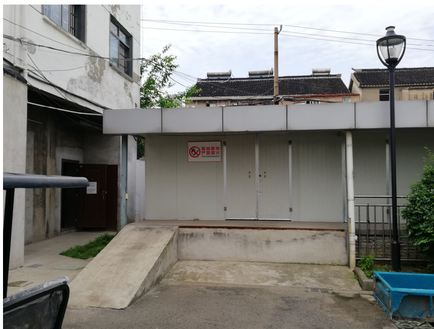
需拆除的氧气储备库
