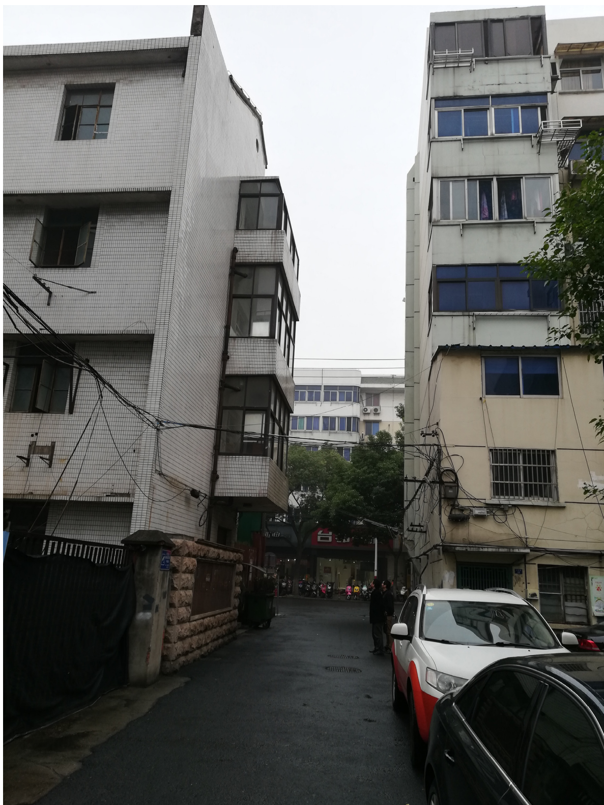
一号楼东侧挑阳台
