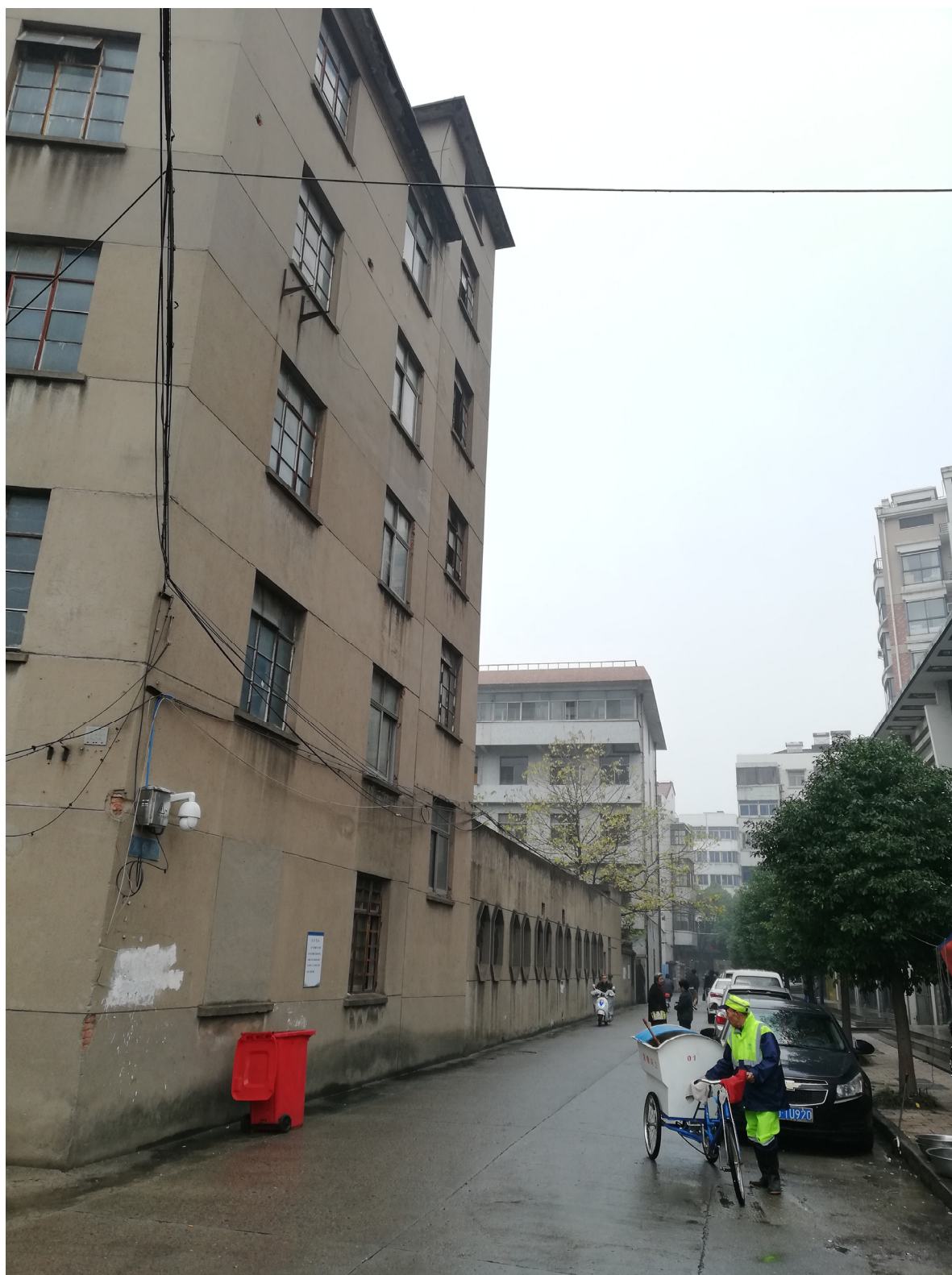
宿舍楼东侧与供应室临街
