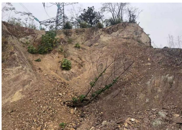
照片 3、上溪镇韵达物流园地块开挖区地表风化层
