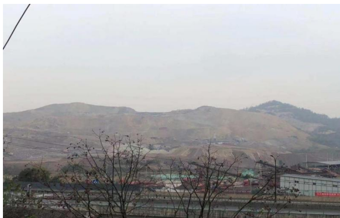
照片 1、上溪镇韵达物流园地块开挖区全貌
